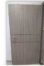
Puerta principal de Seguridad
